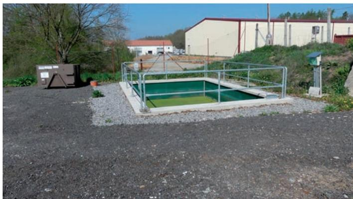
Železobetonová záhybná jímka se skladovací kapacitou 60 m<sup>3</sup> je umístěna vedle kompostovací plochy pod úrovní povrchu, kolem jímky je zábradlí, součástí jímky je čerpadlo pro zavlažovací systém
