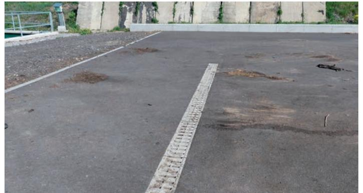
Kompostovací plocha je vodohospodářsky zabezpečena s asfaltbetonovým povrchem (celková výměra plochy 2 484 m<sup>2</sup>). Ve spodní části vyspádované plochy je umístěna záchytná šachta, z které jsou vody z povrchu plochy svedeny do záchytné jímky
