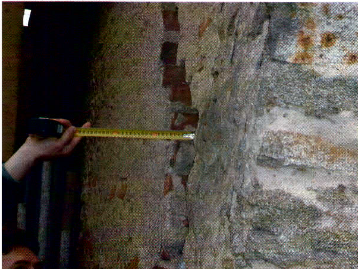
DETAIL VÝŠKOVÉHO ODKLONU
