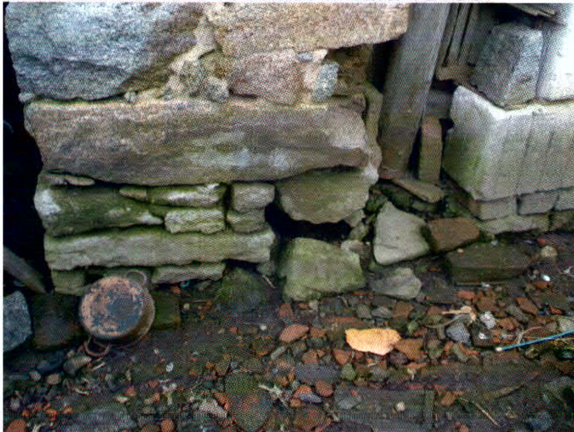
DETAIL STAVU KONSTRUKCE U TERÉNU S CHYBĚJÍCÍMI ZÁKLADY
