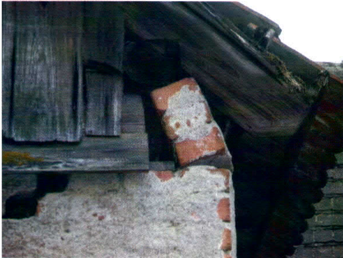
DETAIL STAVU KONSTRUKCE U TERÉNU S CHYBĚJÍCÍMI ZÁKLADY
