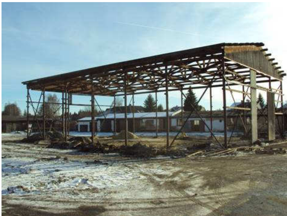
06 Ocelová hala – Stav při demontážních pracích
