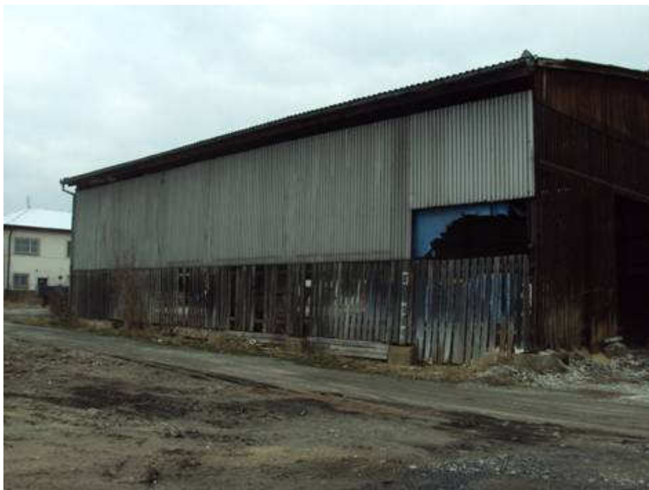
03 Ocelová hala – Stav před demontážními pracemi
