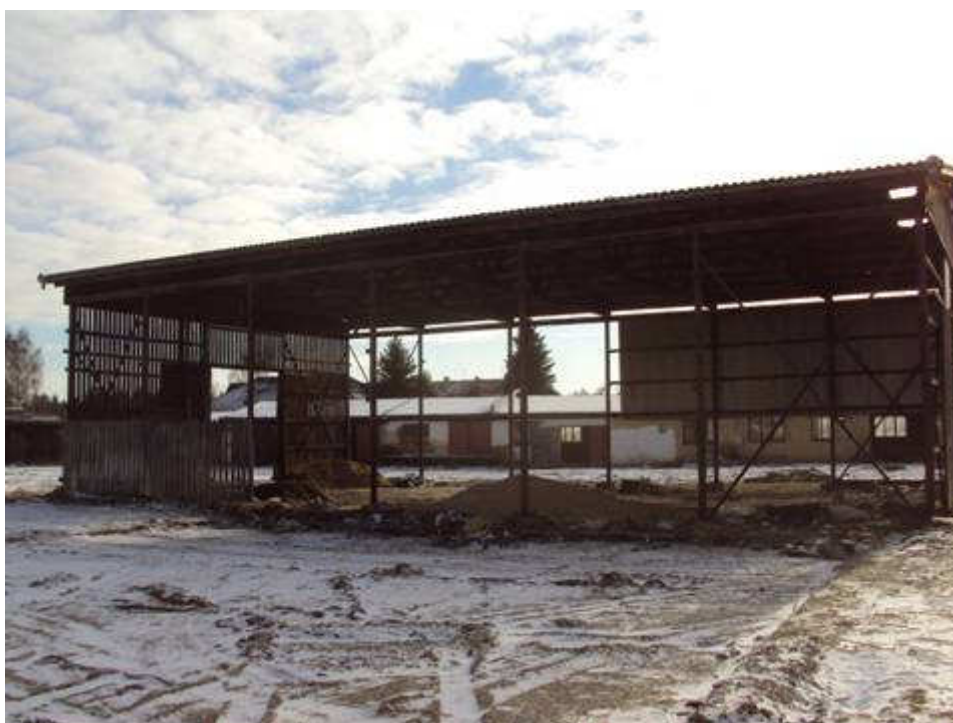
04 Ocelová hala – Stav při demontážních pracích
