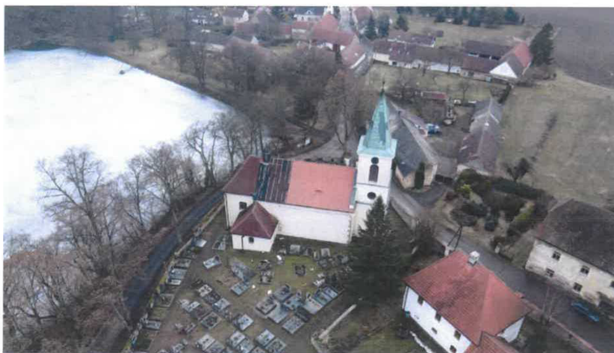
Celkový pohled - severní
