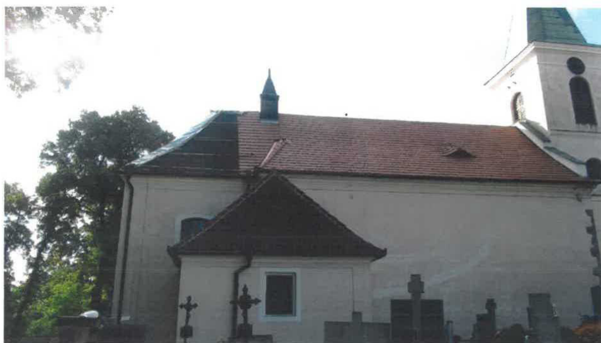
Dokončená etapa 2021 – severní střecha
