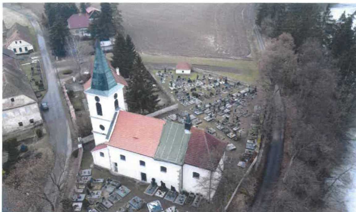
Celkový pohled - jižní
