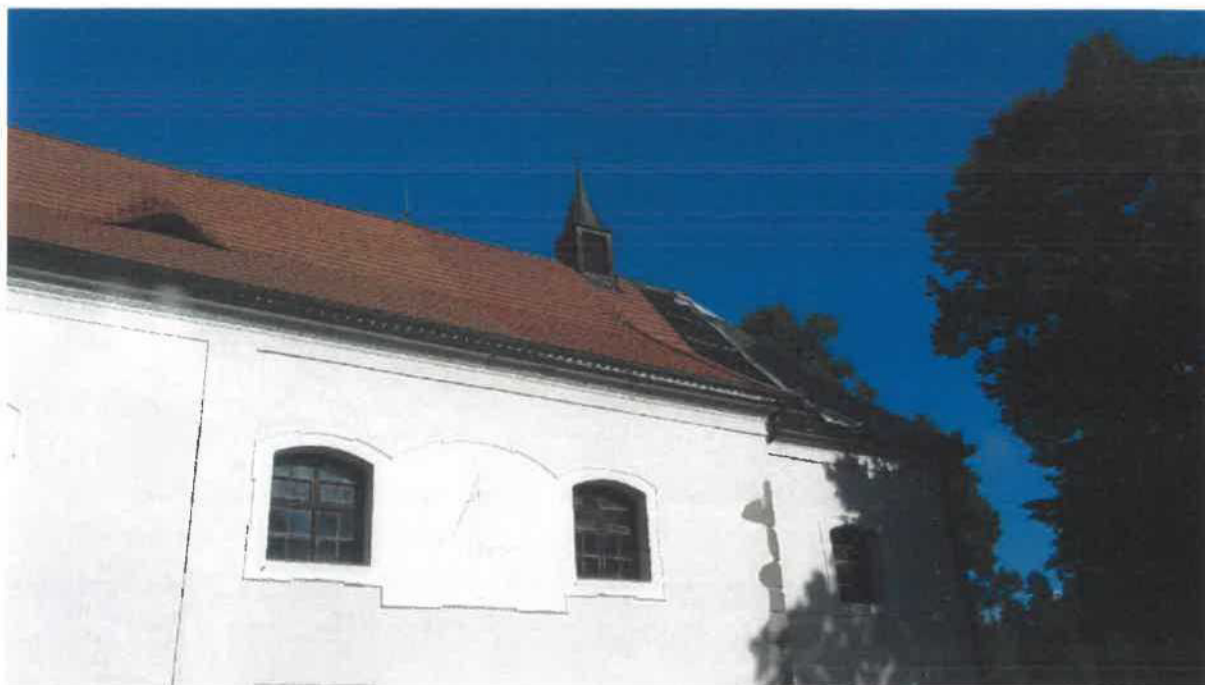
Dokončená etapa 2021 – jižní střecha
