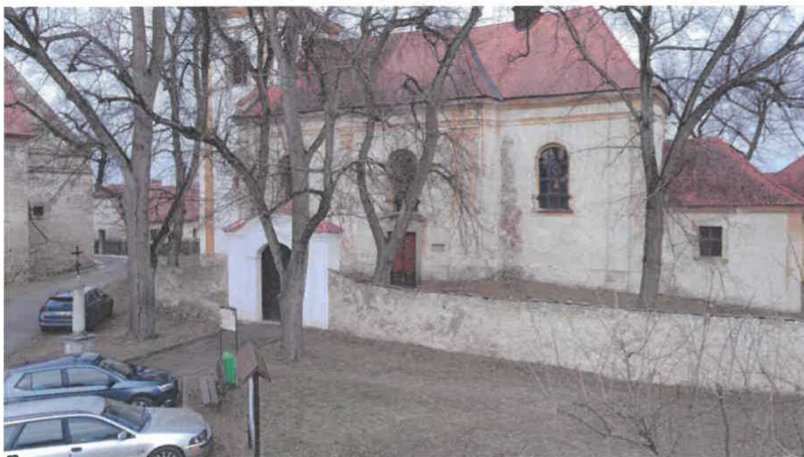
Jižní pohled na fasádu
